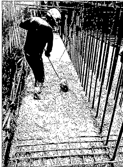
FOTO No.3 FUNDIDA LOSA DE CIMENTACION DE MURO
