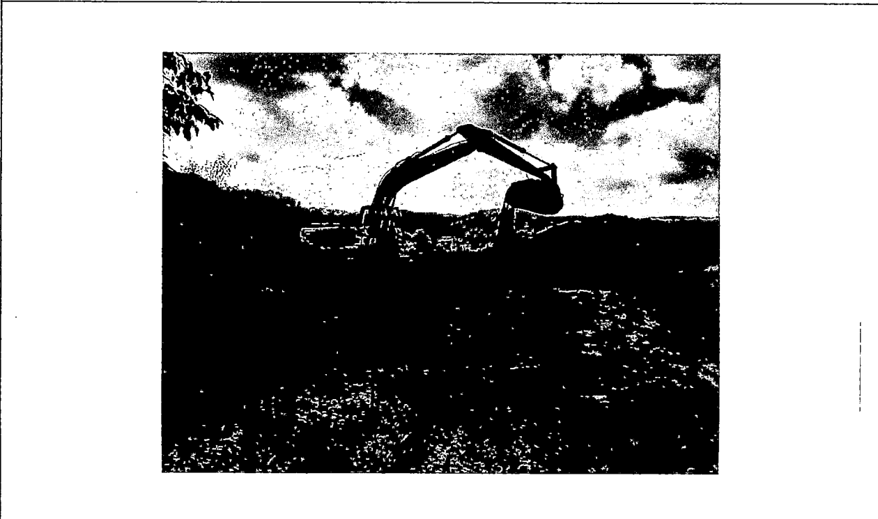
FOTO No.2 EXCAVACION HUMEDALES
