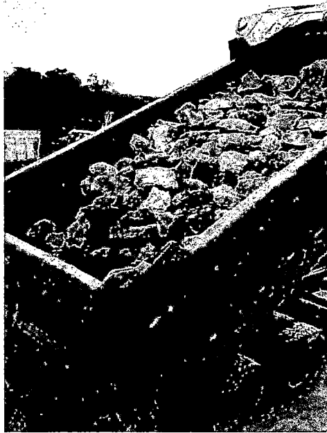
FOTO No.4 RELLENO PIEDRA CICLOPEA
